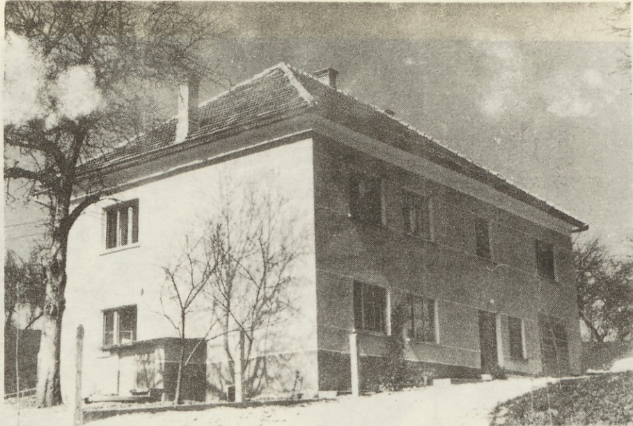
PRVA ŠOLSKA ZGRADBA IZ LETA 1810 DANES STANOVANJSKA ZGRADBA.
