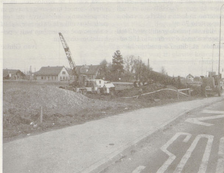
Geološki zavod Ljubljana koplje pod magistralno cesto v Petrovčah prekop za kanalizacijo odpadnih vod nove mlekarne
