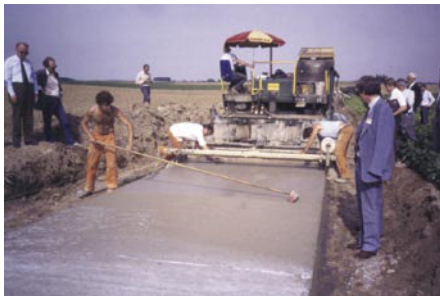
Slika 7 • Gradnja s finišerjem (Vir: ISTU, arhiv)
