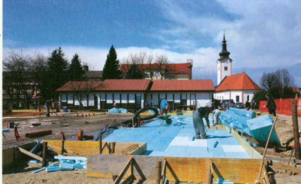
Gradnja talne plošče na lokaciji ob obstoječem vrtcu Šmartno pri Slovenj Gradcu.
