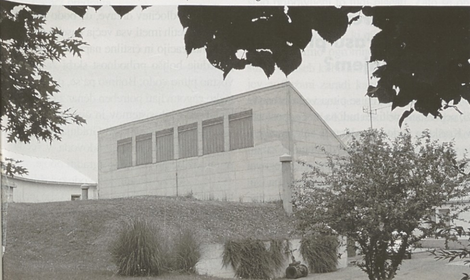
Naprava za čiščenje in kondicioniranje vode Kraškega vodovoda v Selih na Krasu
