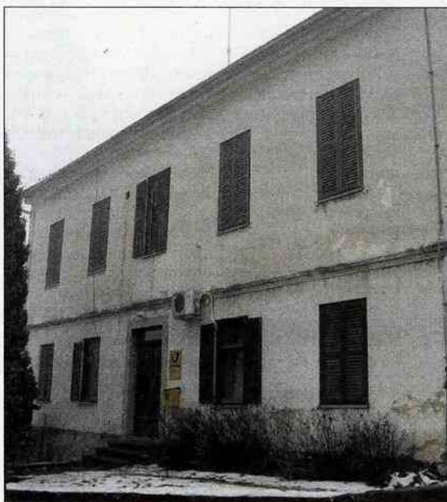
Pošta Buče, ki deluje na območju dveh občin in treh krajevnih skupnosti, domuje v stavbi nekdanje osnovne šole.
