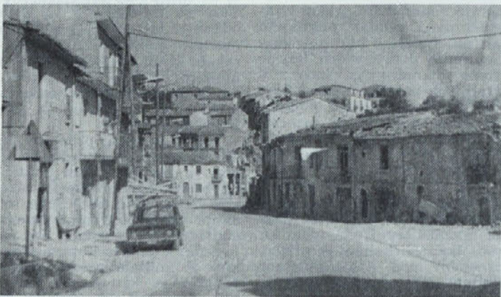
Pusta ulica manjšega mesteca Salca Irpina, katerega večino hiš bo potrebno porušiti. Lepo je videti, da je večina hiš starih.
