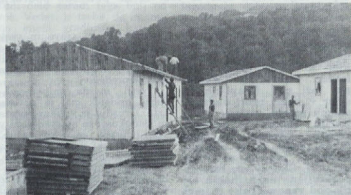
Vse elemente je bilo treba prenašati ročno in tudi pri postavljanju niso uporabljali nobenih dvigal. Pa še blata je bilo za izvoz.
