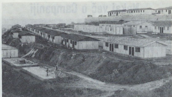
Kako slab teren je bil povsod je videti tudi na tem posnetku. Zemlje je po nekaj metrov globoko in skoraj vsi s katerimi smo govorili so dejali, da se boje, kako bo s trdnostjo temeljnih plošč. Ker so jih gradbinci pripravljali takorekoč tik pred začetkom montaže tudi niso bile uležane. Ob podpisu prevzema so skoraj povsod napisali, da Jelovica-Gradis ne priznavata reklamacij ki bi nastale zaradi ugrezanja plošč.
