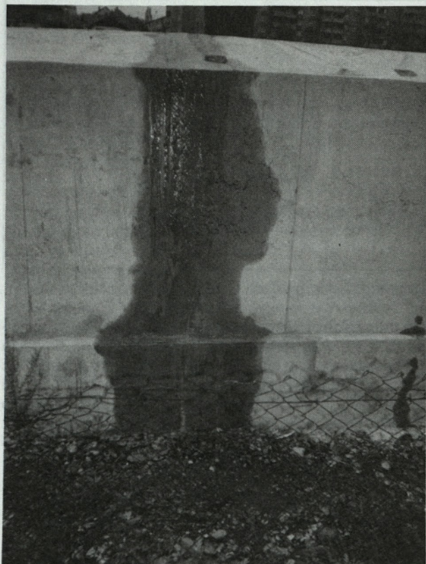
Slika 5: Primeri netesnosti na obbetoniranem cevovodu in na stikih cevi
