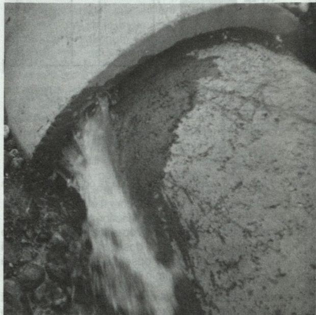
Slika 5: Primeri netesnosti na obbetoniranem cevovodu in na stikih cevi
