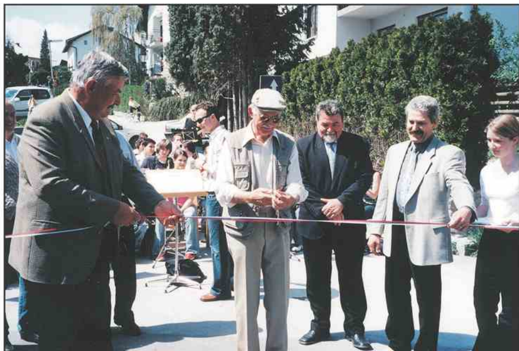
Na začetku obnovljene ceste, pod katero se skrivajo novi komunalni vodi, so prerezali slavnostni trak.
