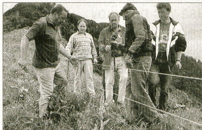
Postavljanje ograje na Kočni
