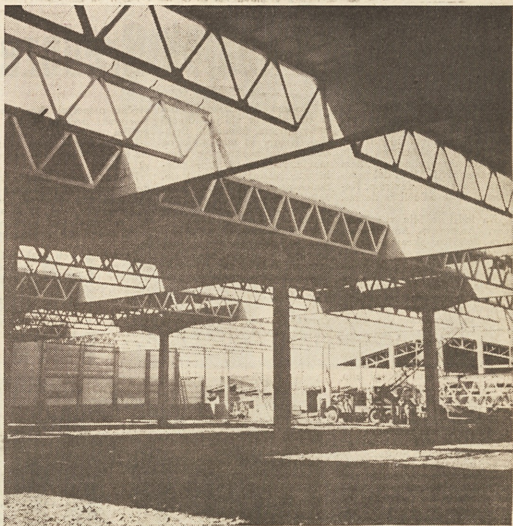
Pogled na delno pokrito halo, zadaj stene in siporex zidnih elementov
