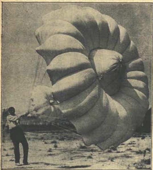
Amerikanski iznajditelj Baker je sestavil dvojno padalo, s katerim bodo skakali iz zrakoplovov. Manjše spodnje padalo varuje padajočega pred neprijetnim zibanjem med potjo na tla.
