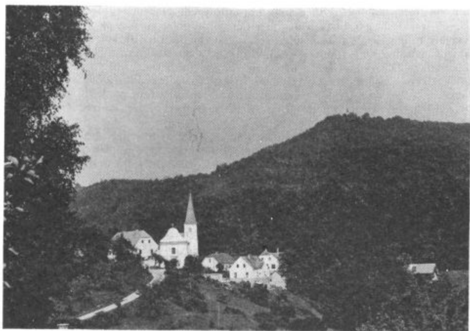
Središče Galicije predstavljajo cerkev, župnišče, šola in stanovanjska zgradba za učitelje.
