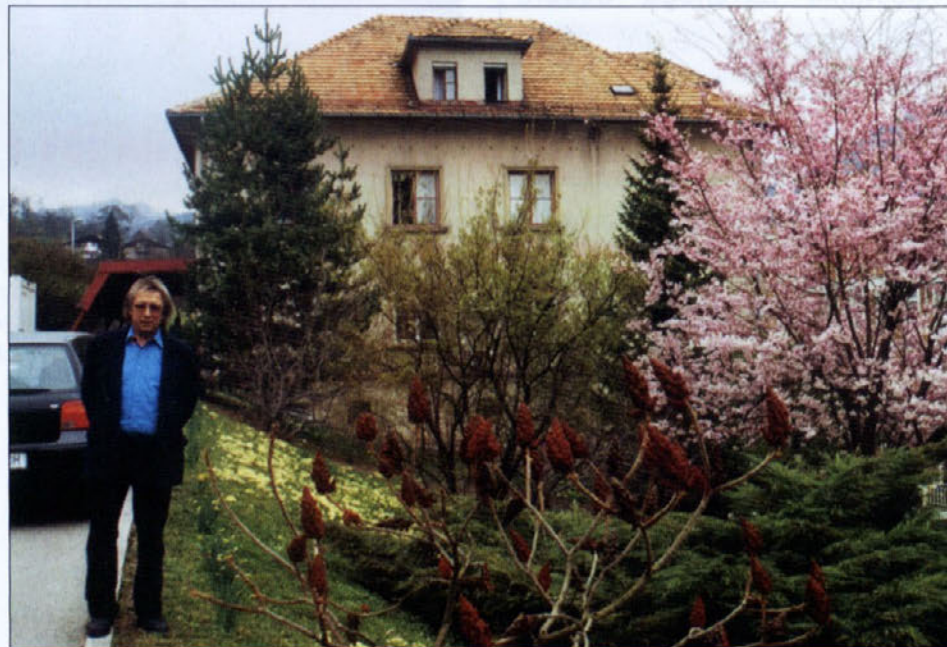
Zgradba Dializnega centra Splošne bolnišnice Trbovlje bodo preuredili in pridobili nekaj (pre)potrebne prostora. Spredaj: predsednik DLB Zasavje Bojan Frangež. (mab)
