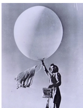
Slika 40.36 Vremenska sonda. Helijev balon ponese v višave škatlo z merilniki za tlak, temperaturo in vlago ter z radijskim oddajnikom, ki sporoča izmerke sprejemniku na tleh. (NOAA)
