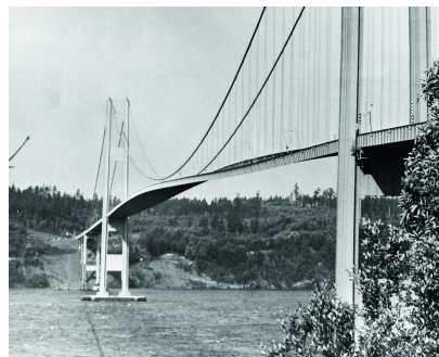
Slika 34.11 Vzbujeno nihanje mostu v Tacomi. Šibek spremenljiv veter ravno pravšnje frekvence je most spravil v resonantno nihanje in ga povsem porušil. (New York Times)
