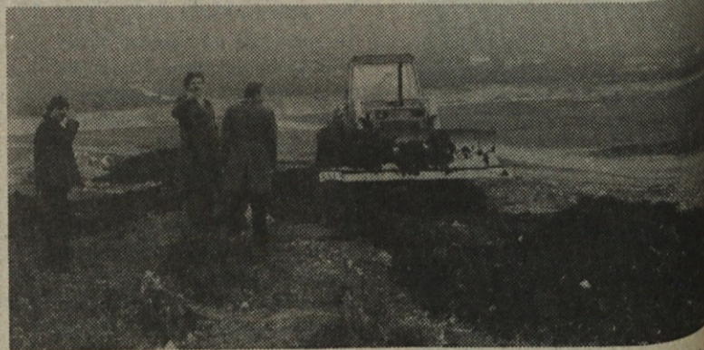
Tehnični direktor DO Raduša Azem Sadikaj daje zadnja navodila za pričetek zemeljskih del.
