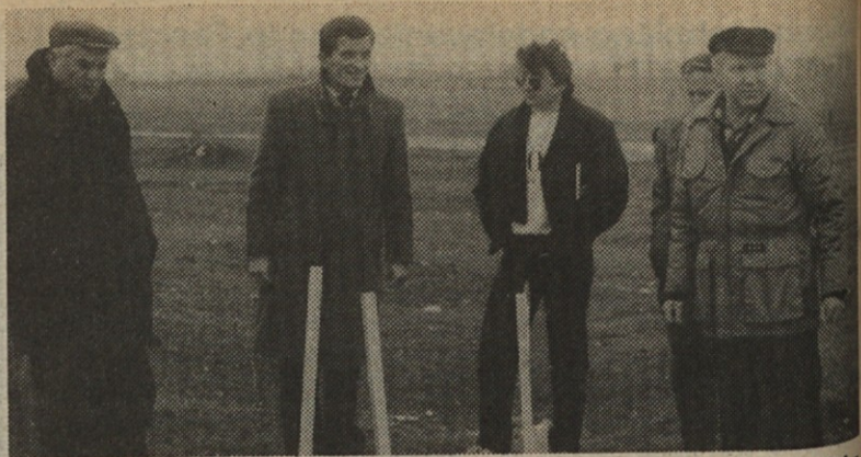
Zakoličba platoja tovarne stavbnega pohištva Raduša v Istoku. Na sliki z leve proti desni stojijo: figurant, Halit Kabashi, direktor geodetske uprave v Istoku, Rudi Juršek, vodja gradbišča iz tozda GE Jesenice, figurant in Bojan Jeločnik, vodja projekta v Raduši.
