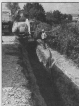
Gradnja kanalizacijskega omrežja v občini Krško se nadaljuje.
