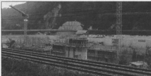
HE Krško v izgradnji
