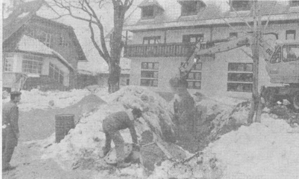
Gradnja na Rakitni se bliža koncu
