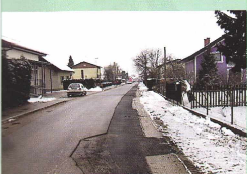
Vodovod v KS Krog
