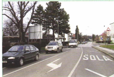
Javna razsvetljava, Severjeva ulica, Murska Sobota
