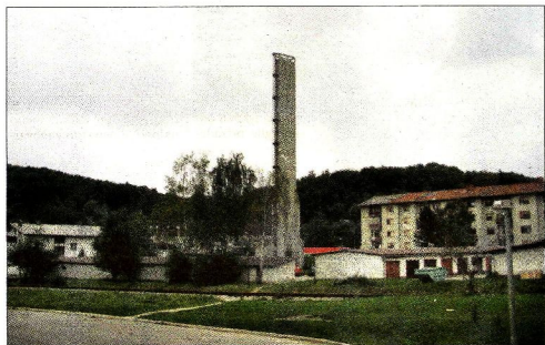
Sporu zaradi predvidene ukinitve skupne kotlovnice v Ratanski vasi še ni videti konca.
