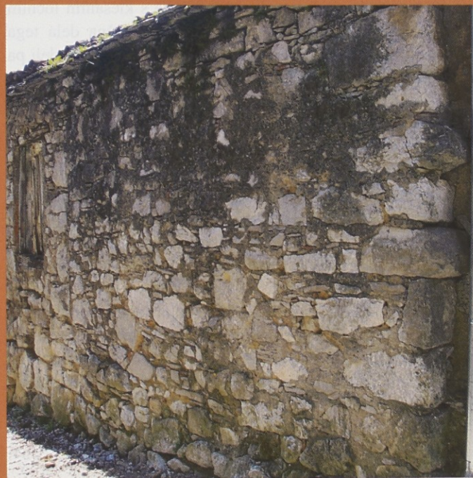
Primer fasade, ki je danes kamnita, nekdanj pa je bila v celoti zaščitena z ometom
