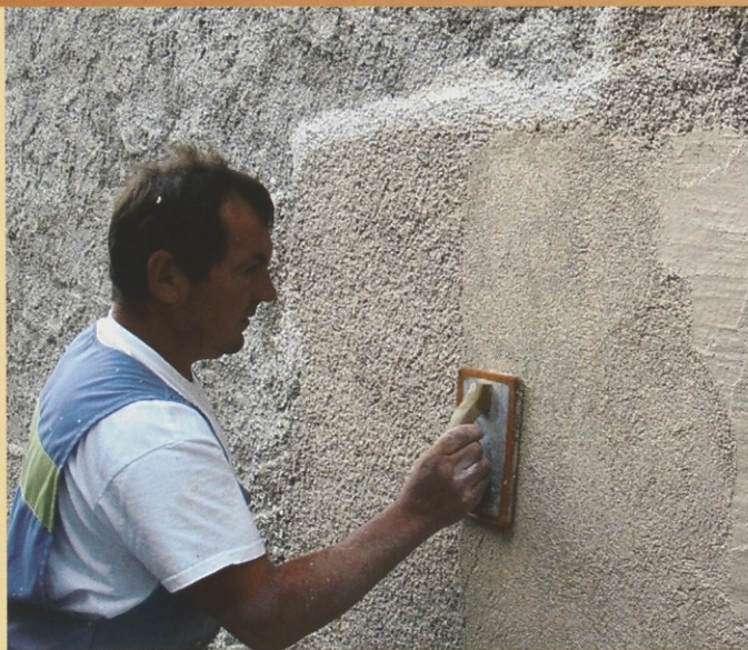
Vzorec narejenega fino zaribanega ometa
