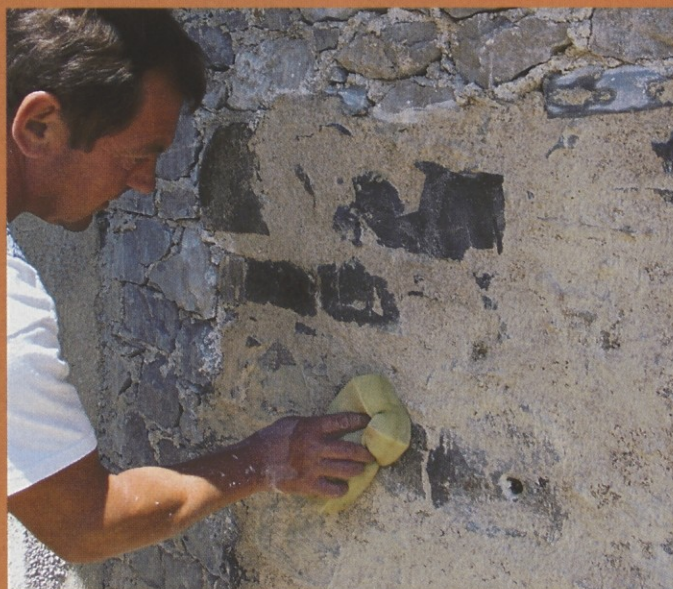
Vzorec fugiranja zidu
