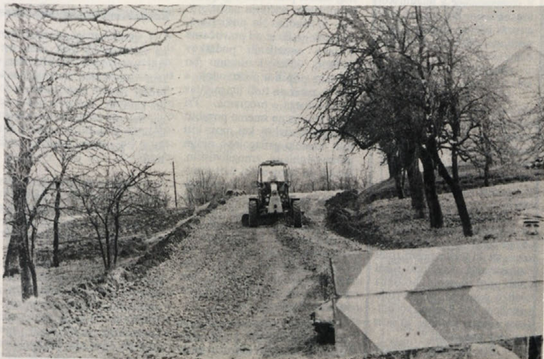
Delo pri asfaltiranju ceste v Mirni peči lepo napreduje. Če vreme ne bo nagajalo, se bodo Mirnopečani vozili po asfaltu že v začetku leta 1975. (Foto: P. Riznič)
