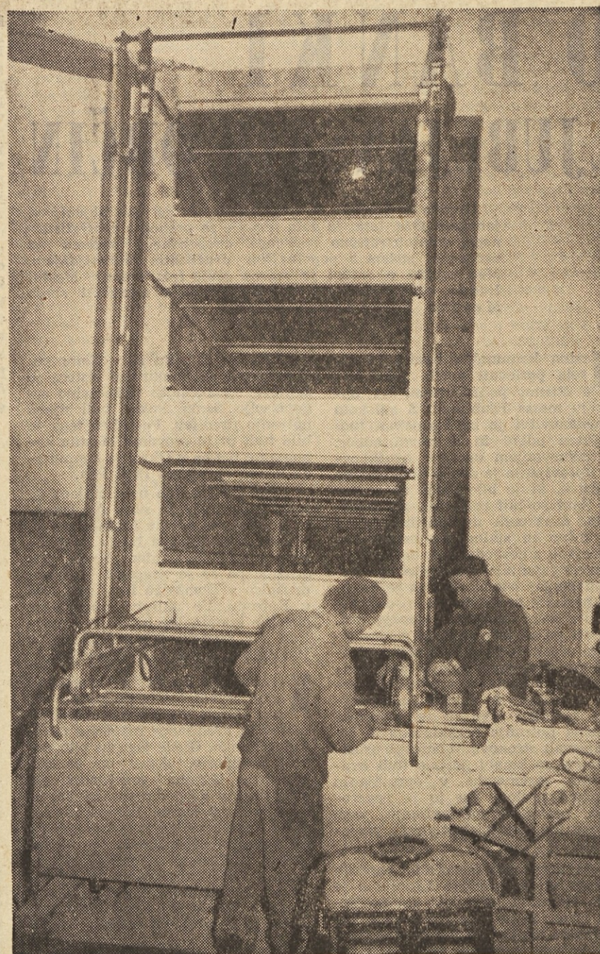
»Monterji opravljajo še zadnja dela pri opremlitvi proizvodne hale nove tovarne testenin v Ljubljani«
