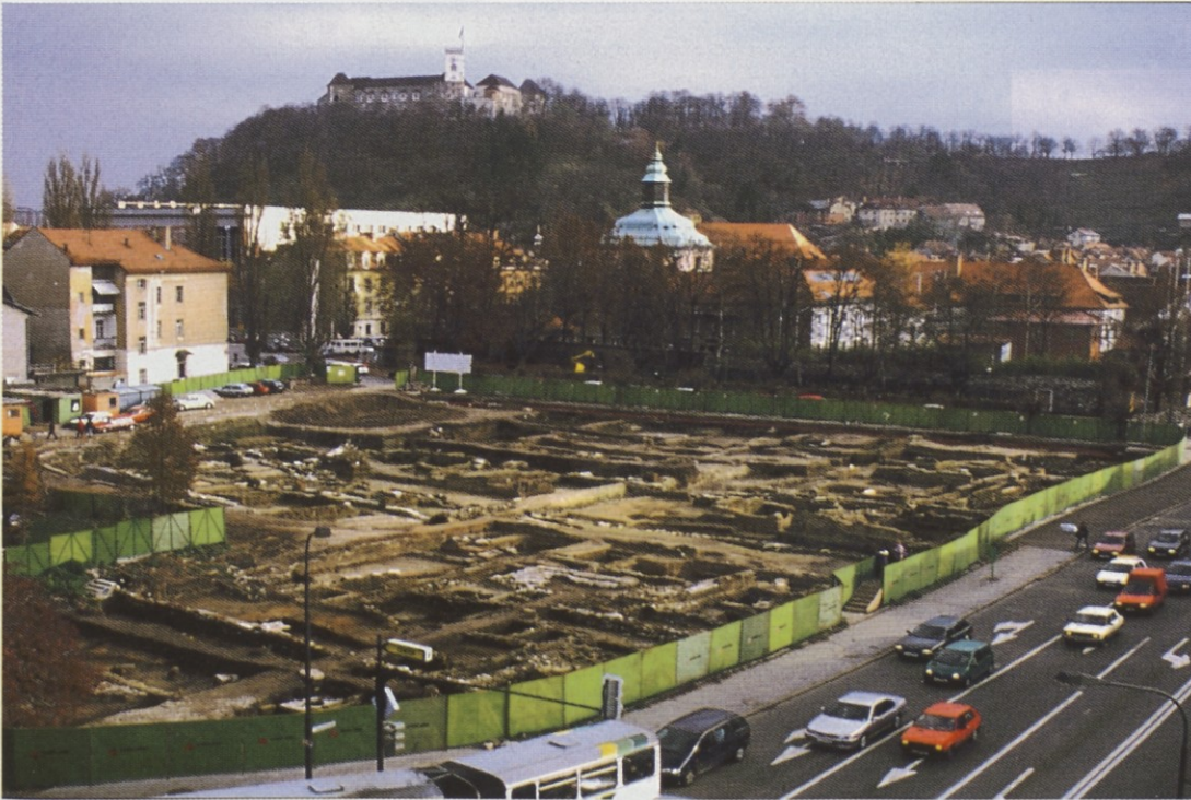
Kompleks izkopavanj Emona za novo Univerzitetno knjižnico Ljubljana (UKL) med Emonsko, Aškerčevo, Slovensko in Rimsko cesto v Ljubljani Foto: D. Snoj.
