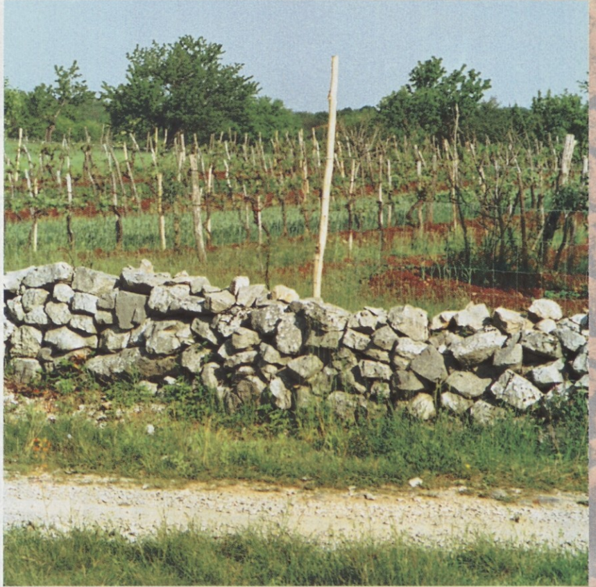
Tipi kraških zidov in način spravila kamna z obdelovalnih površin; a - enoredni suhi zid
