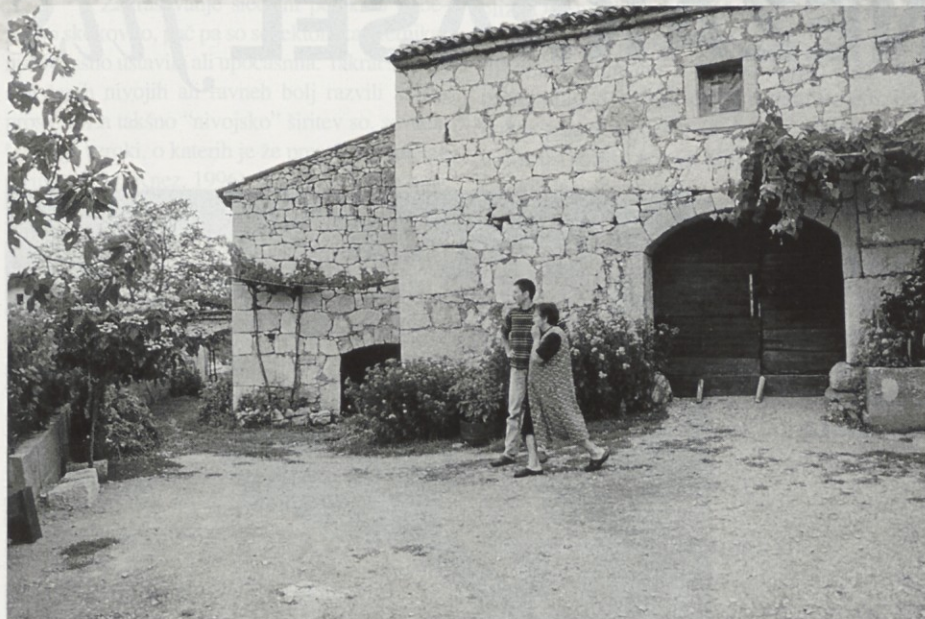
Bivalnim prostorom so prizidana gospodarska poslopja (skedenj, lupa, lupca, štala, loža, kozjak, velb). Značilnost vseh stavb pa so velika vhodna vrata... Na sliki domačija Pri Rejčevih.
