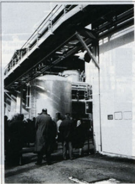
Pred novim poslopjem v TKI stoji posoda za slanico, ki so jo gumarji gumirali na mestu samem, za njo pa topilnik soli.
