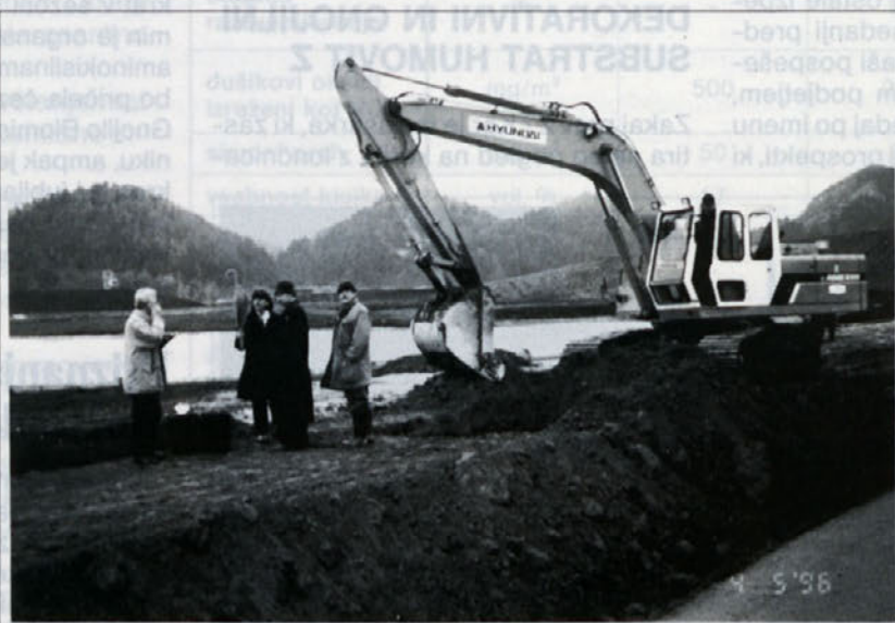
Jemanje vzorca odloženega stabilizata po 28. dneh na odlagališču TEŠ
