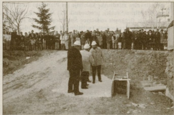
Polaganje temeljnega kamna za gradnjo prizidka k laporski osnovni šoli. Foto: S. Brbre
