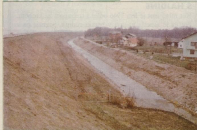
Rekonstrukcija levobrežnega drenažnega jarka.
