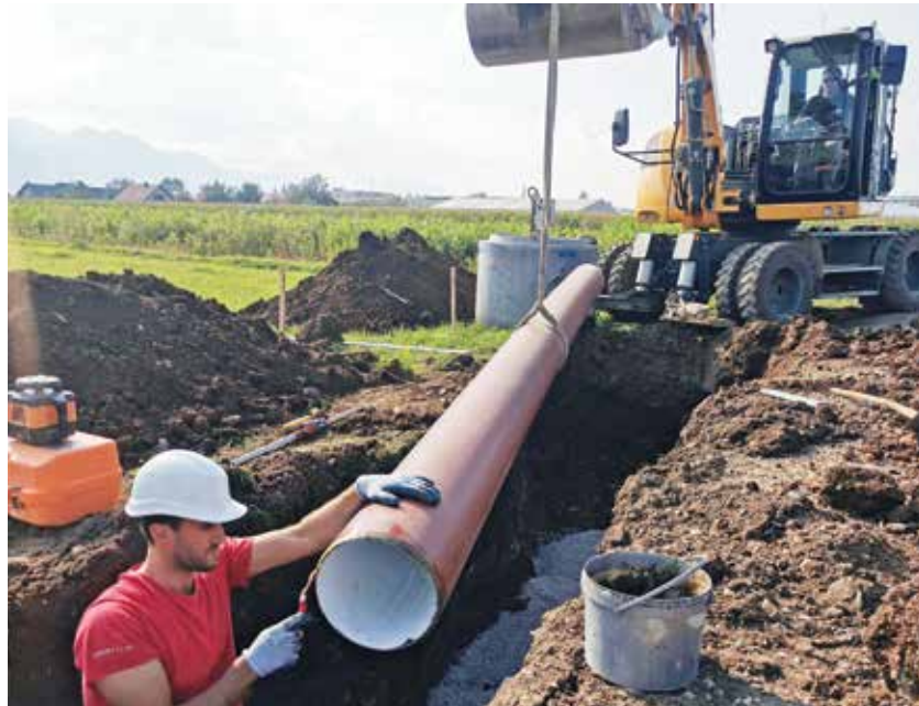
Pri gradnji kanalizacije v Šempetru
