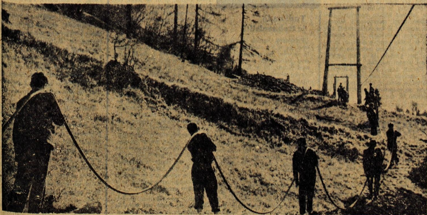
Dela pri gradnji žičnice na Črni vrh dobro napredujejo. Gradbenemu podjetju so ta teden prišli na pomoč dijaki jeseniške gimnazije, ki so položili električni kabel
