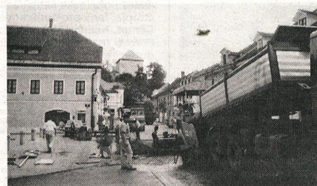
Asfaltiranje glavne kamniške ceste
