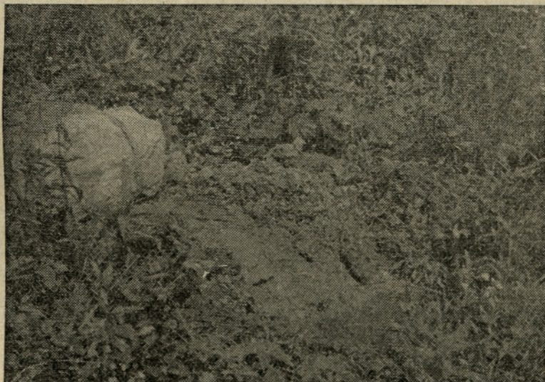
Plitvo vkopana okrogla sidra so pogosto vzrok zrušitve žičnic
