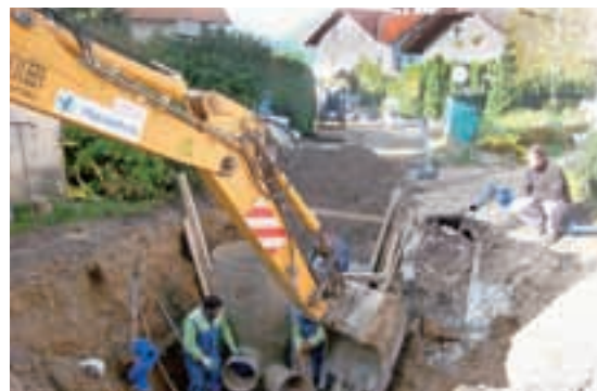
V Zgornjih Pirničah pospešeno gradijo kanalizacijo.
