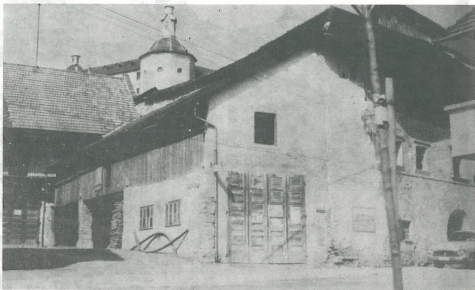
Martinova garaža ob mestnem obzidju pred občino, desno stara Martinova hiša, levo podrta Martinova hiša ob obzidju, sedaj prostor pred Miholom (Original Martin Eržen, foto Šturm).
