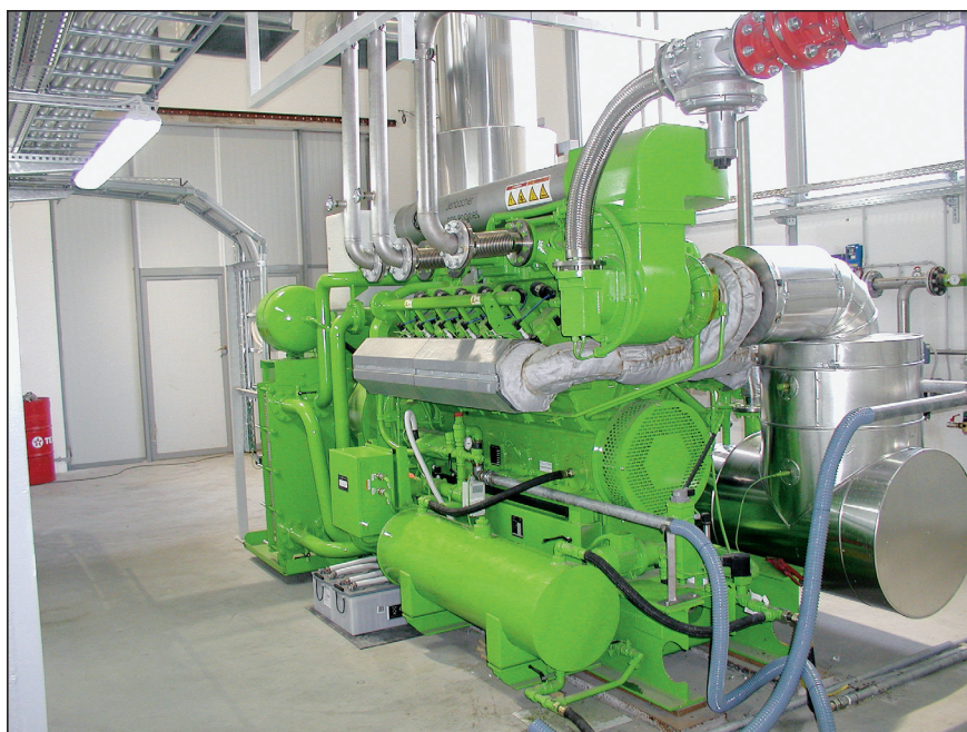
Kogeneracija na bioplin, Količevo Karton
