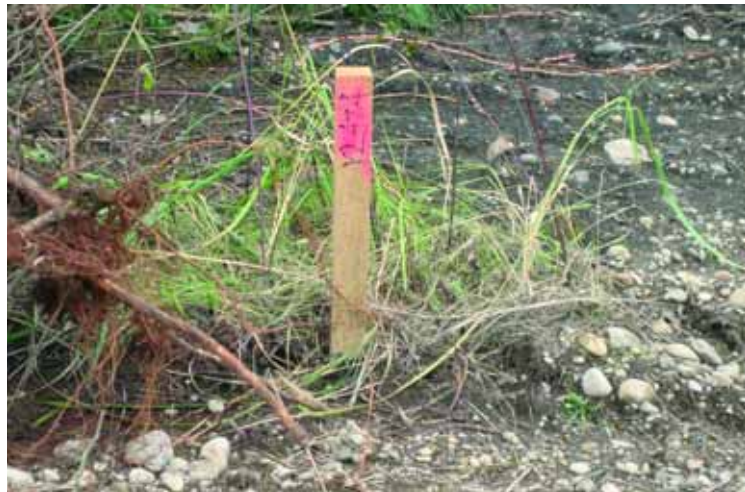
Prvi količek za sončno elektrarno je že postavljen
