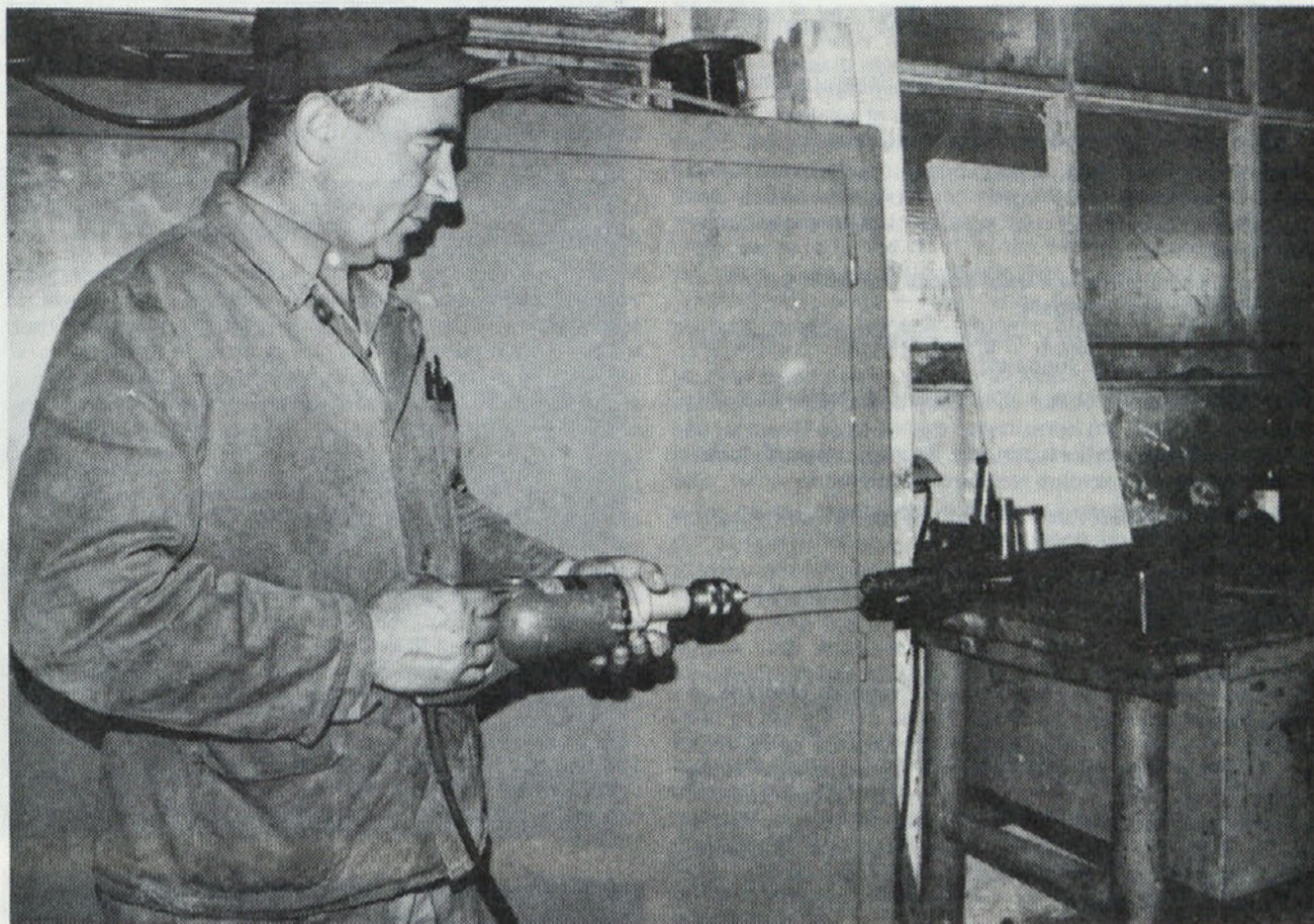
Naprava za čiščenje vodil za CO 2 -varilne aparate - Racionalizacija Franca Pečečnika iz TOZD ESO. Naprava omogoča okoli 14 000 dinarjev letnega prihranka, nagrada, ki so jo avtorju odmerili zanjo po našem pravilniku o racionalizaciji, pa je kaj malo spodbudna - dobil je le enkratno nagrado v znesku 1 000 dinarjev.
