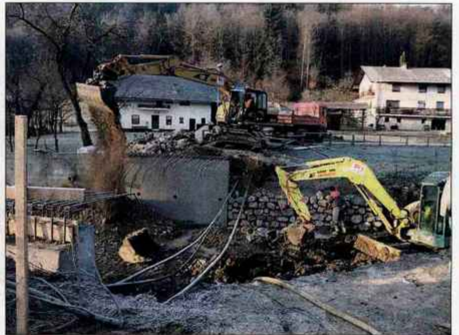
Most na Kamnjaku že obnavljajo. | Foto: Tina Dokl
