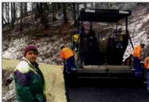
Ta teden so začeli asfaltirati začasno cesto v Davčo.
