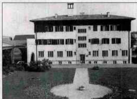
Stavba šole v Čirčah
