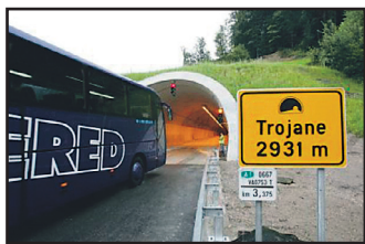
Po nesreči je v predoru zagorelo in ostal je zaprt za promet.
