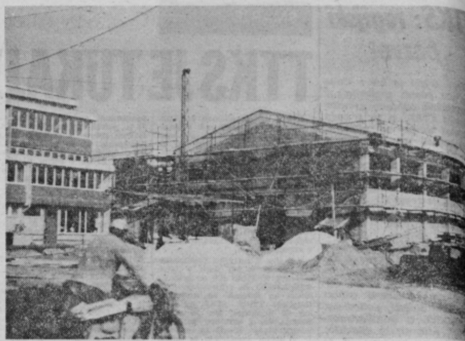
TUDI TELOVADNICA NOVA. Otvoritev nove osnovne Sole v Sempetru bo 29. novembra. Sola je že dograjena, telovadnico pa bodo tudi zgradili do otvoritve. Dolga bo 24 m, široka 16 ter visoka 6 m. Na sliki vidimo na levi strani del nove Sole, na desni pa telovadnico v gradnji. Foto: T. Tavčar
