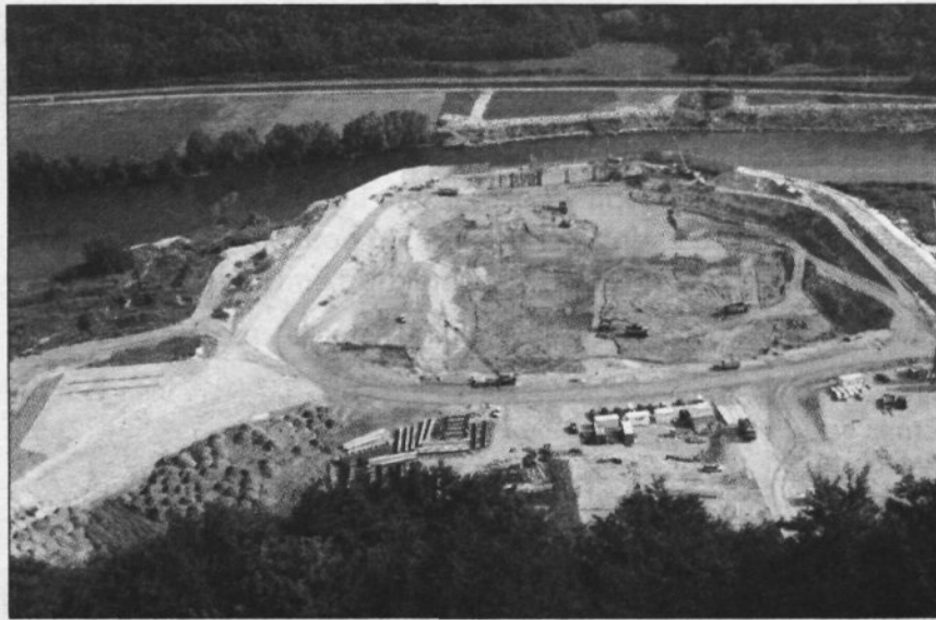
Gradbišče HE Blanca, foto: Ljubo Motore
