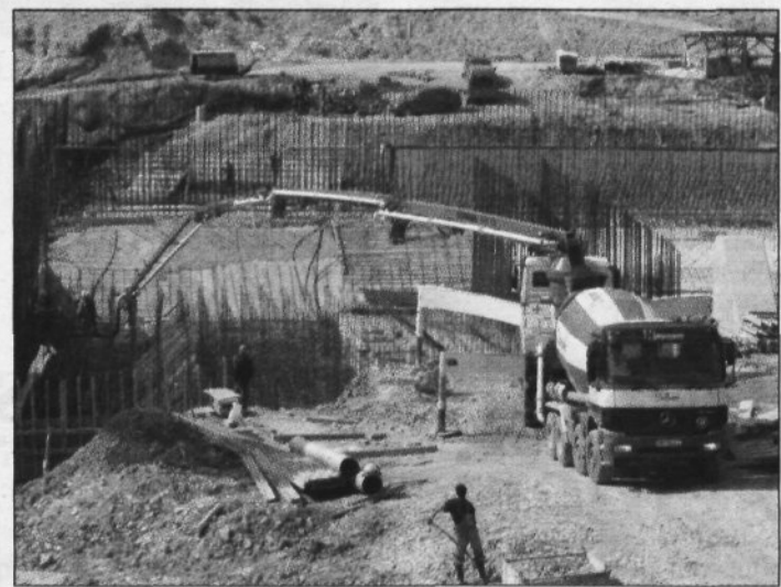
Na gradbišču HE Blanca tedensko vgradijo od 1500 do 2000 kubičnih metrov betona, včasih tudi več. Beton vozijo iz dveh betonarn: Savabetonove na Logu in Hribškove pri HE Boštanj.
