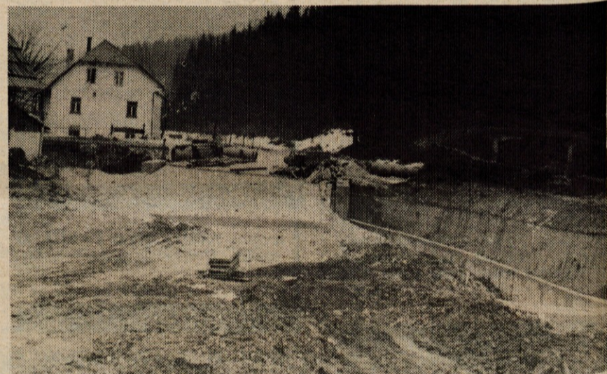
PODKOREN - Delavci SGP Gradbinec opravljajo zaključna dela pri gradnji novega mostu čez Savo v Podkorenu. Omiliti nameravajo dokaj oster ovinek stare ceste. - Foto: B. B.
