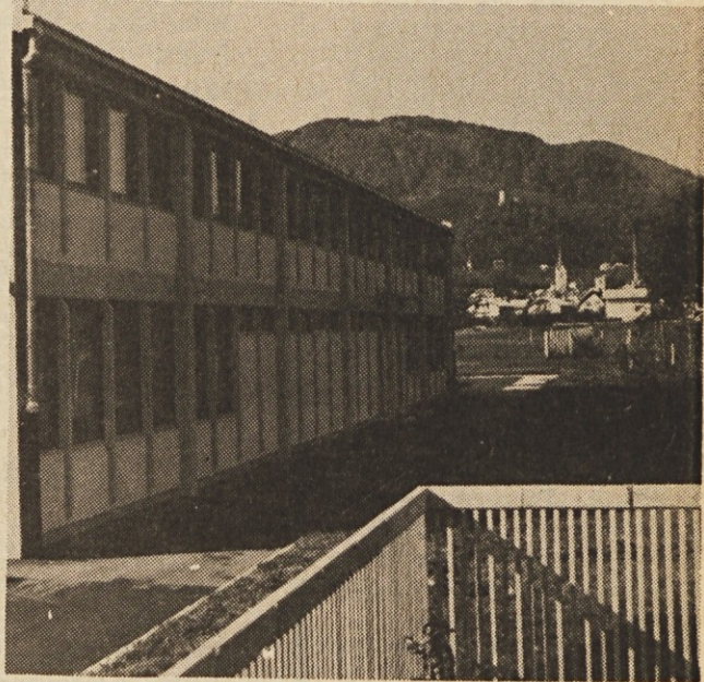
Fasadni del aneksa obrata Elektromontaže v Slovenskih Konjicah, v katerem so garderobe, menza, sanitarije, vratarska loža, v prvem nadstropju pa pisarniški prostori
