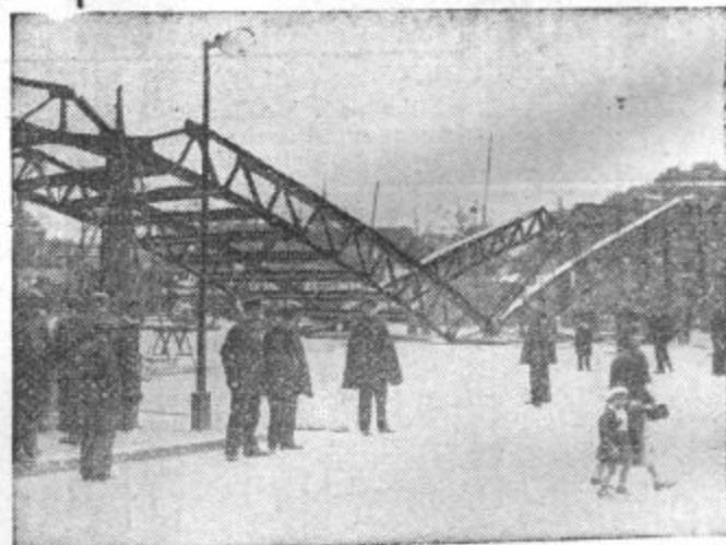
NAGLICA NI NIKJER PRIDA. Na razstavišču pariške svetovne razstave se je pred dnevi zgodila nesreča. Neki most v bližini Pont des Invalides se je zrušil in pod lokom je obležal s smrtnonevarnimi ranami en delavec. Poslanec Goiran je zaradi stavbne nesreče vložil interpelacijo v parlamentu.
