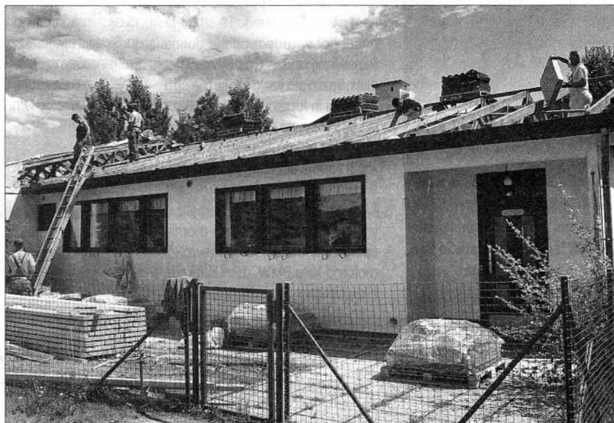
Prenovljena streha na vrtcu v Nazarjah bo zdravju prijaznejša in energetske učinkovitejša (foto: Marija Lebar)
