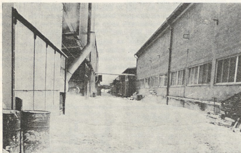
Tole ni sneg, pač pa fenomen, imenovan PENA, ki se je 17. februarja ves dan valila izpod petega papirnega stroja na transportno pot med zgradbo V. PS in premaza. Transportni delavci seveda niso mogli uporabljati te poti in so morali prepeljati papir izpod nadstreška pri premazu okoli stavbe do vagonov, ki so jih morali naložiti za odpremo.
