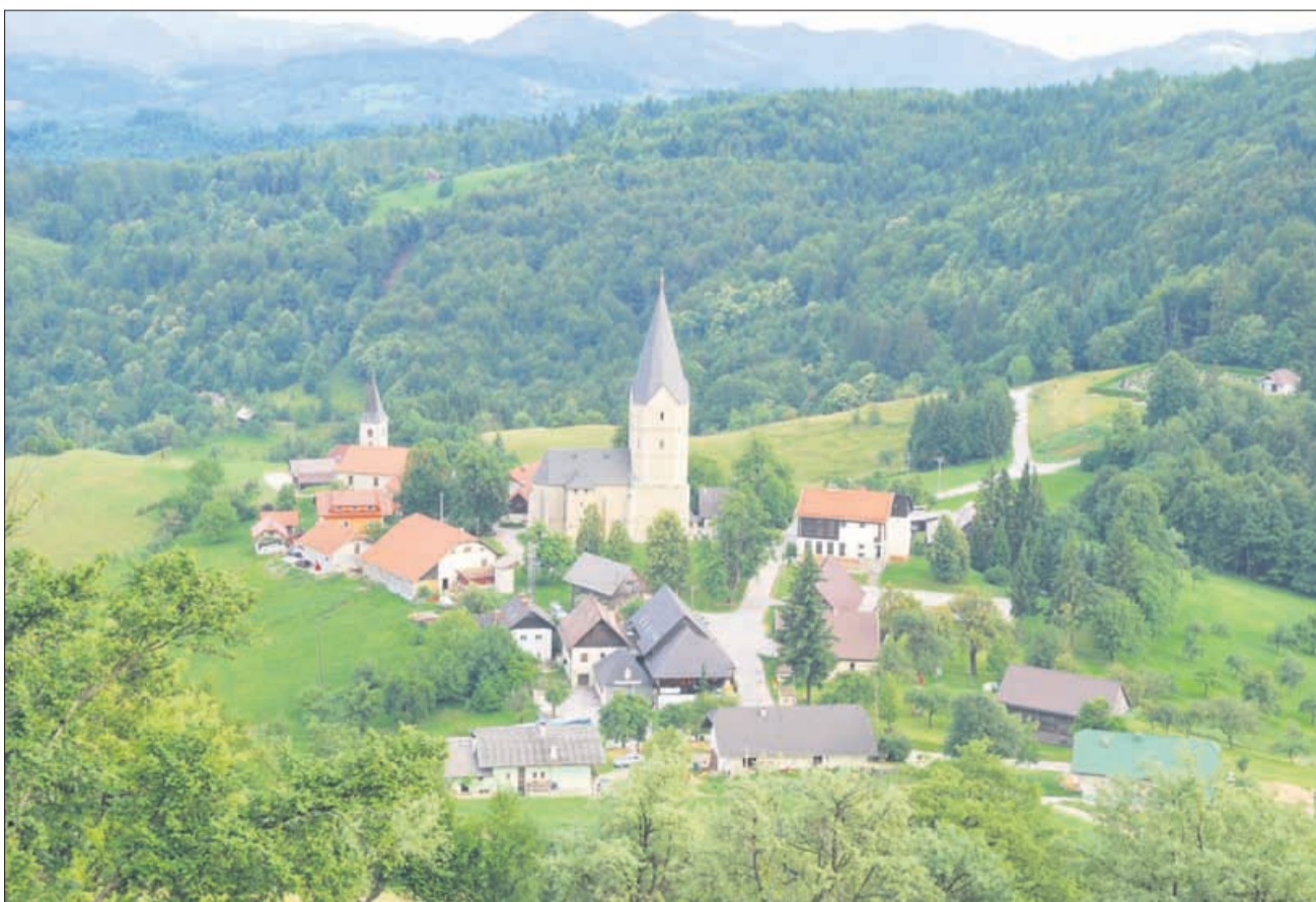
Pogled na Svetino, na mogočno romarsko cerkev sv. Marije Snežne ter manjšo sosednjo, ki je posvečena sv. Križu. Pred nekaj dnevi se je končala prva faza obnove sv. Križa.
