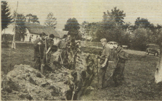
POLAGANJE TELEFONSKEGA KABLA — Skupina vojakov te dni polaga telefonski kabel na relaciji Murska Sobotica — Radenci. To delo vojaki opravljajo v dogovoru s PTT podjetjem v Murski Soboti.
