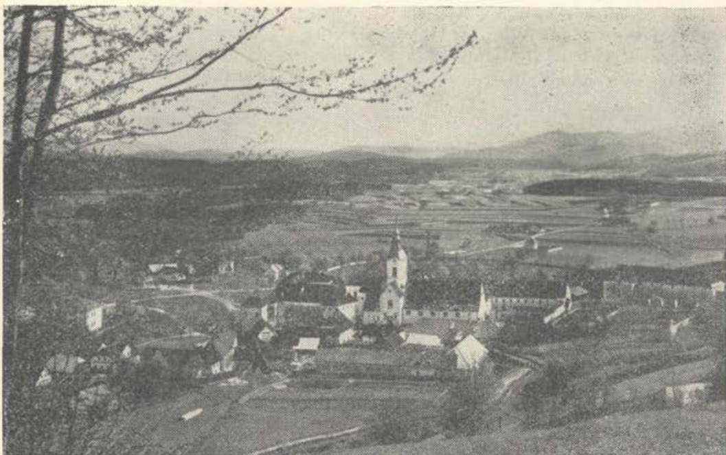
Pogled na Stično s samostanom
