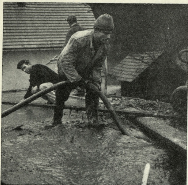
7. Liti elementi (stene in stropovi) iz lahkega elektro-filtrskega betona nudijo odlične možnosti tako glede nosilnosti elementov, kakor tudi v pogledu toplotne zaščite. Lahki beton, izdelan na ta način, ima \gamma = \text{ca. } 1500 \text{ kp/m}^3 teže ter dosegamo z njim marko 200 \text{ kp/cm}^2 . Slika kaže primer aplikacije na stanovanjski stavbi v režiji GP ŽGP Ljubljana
