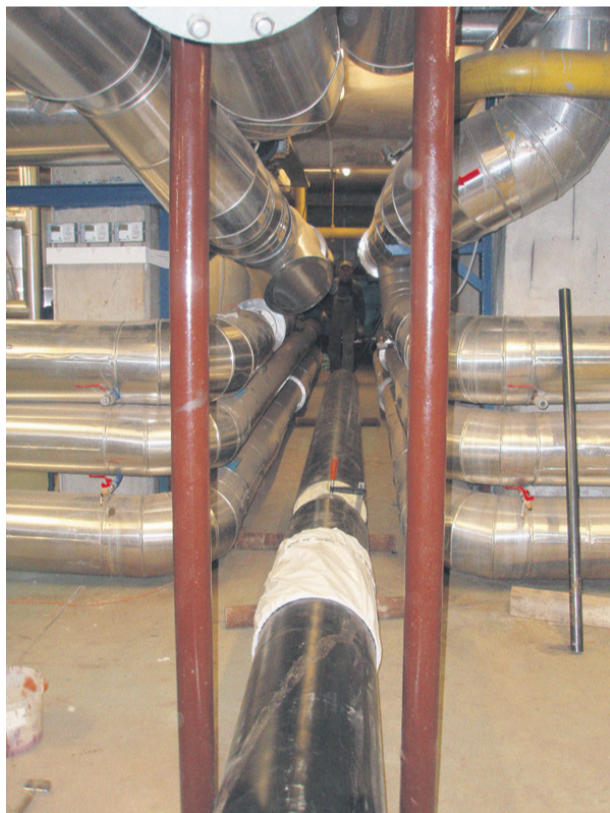
V Energetiki Celje so pred začetkom ogrevalne sezone opravili nekaj posodobitev: na fotografiji obnovljene predizolirane vročevodne cevi iz kotlarne Nova vas, ki so speljane po tunelu do kinete na Grevenbroichovi.
