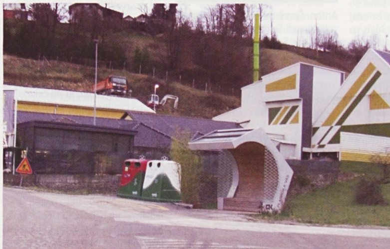
Pred asfaltno bazo stoji avtobusna postaja, ki jo je podjetje obnovilo pred letom dni.
